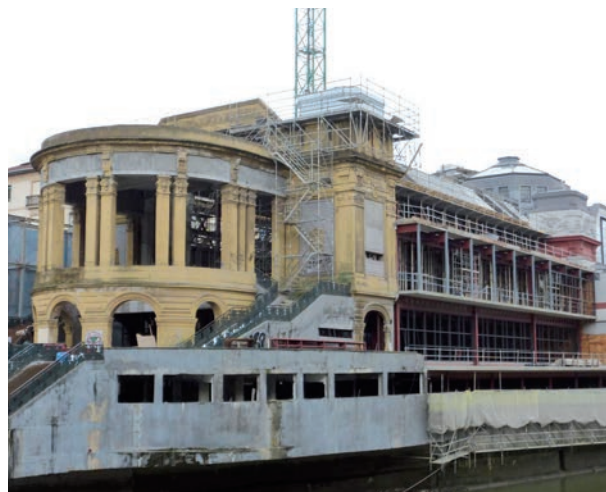
El mercado durante la reconstrucción.
