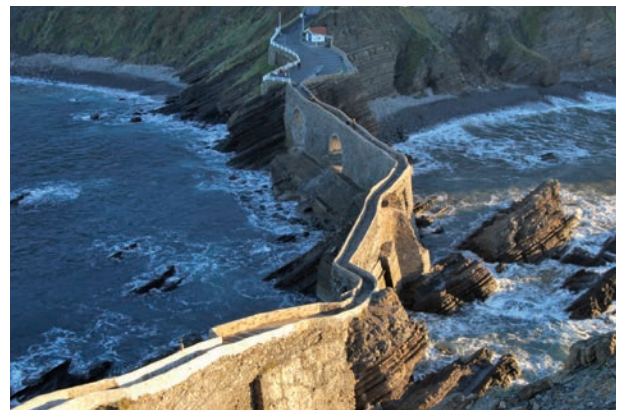
Escaleras de acceso
